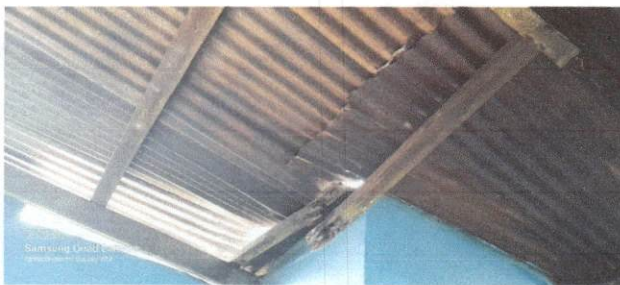
Foto 5: Sustitución de lámina, por lámina troquelada aluzinc calibre 26
