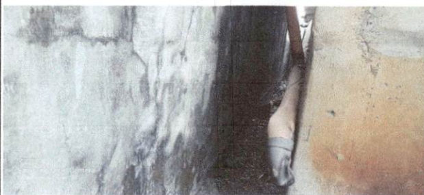
Foto 3: CANALES Y BAJADAS DE AGUA PLUVIAL
