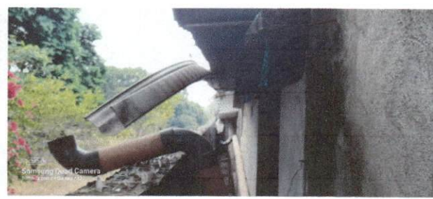
Foto 6: CANALES Y BAJADAS DE AGUA PLUVIAL
